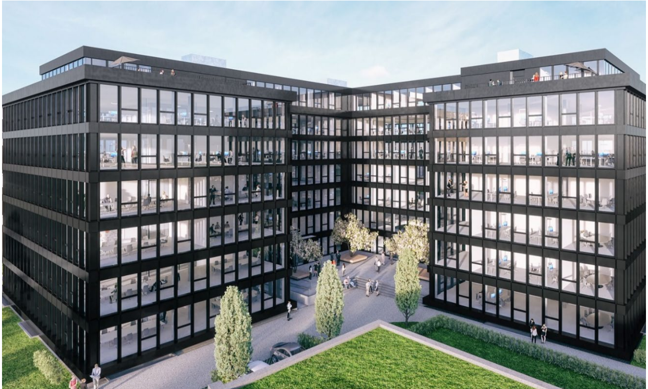
TONIQ1, Wanheimer Straße | Bildnachweis: ©Hartmann Architekten
